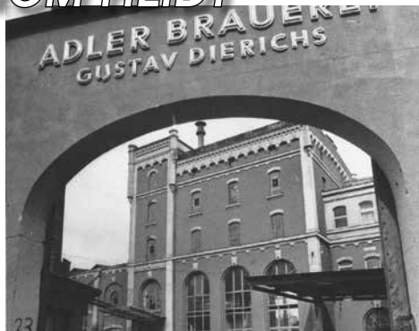
Kurt Keil fotografierte das leerstehende Brauerei-Gebäude 1978. Zwei Jahre später kamen die Bagger. Foto: Kurt Keil
