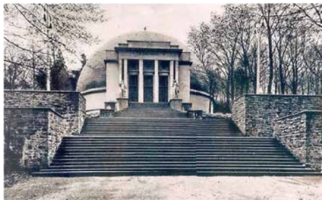
Das Barmer Planetarium wurde im Krieg beschädigt und 1955 endgültig abgerissen. Foto: Archiv BVV
